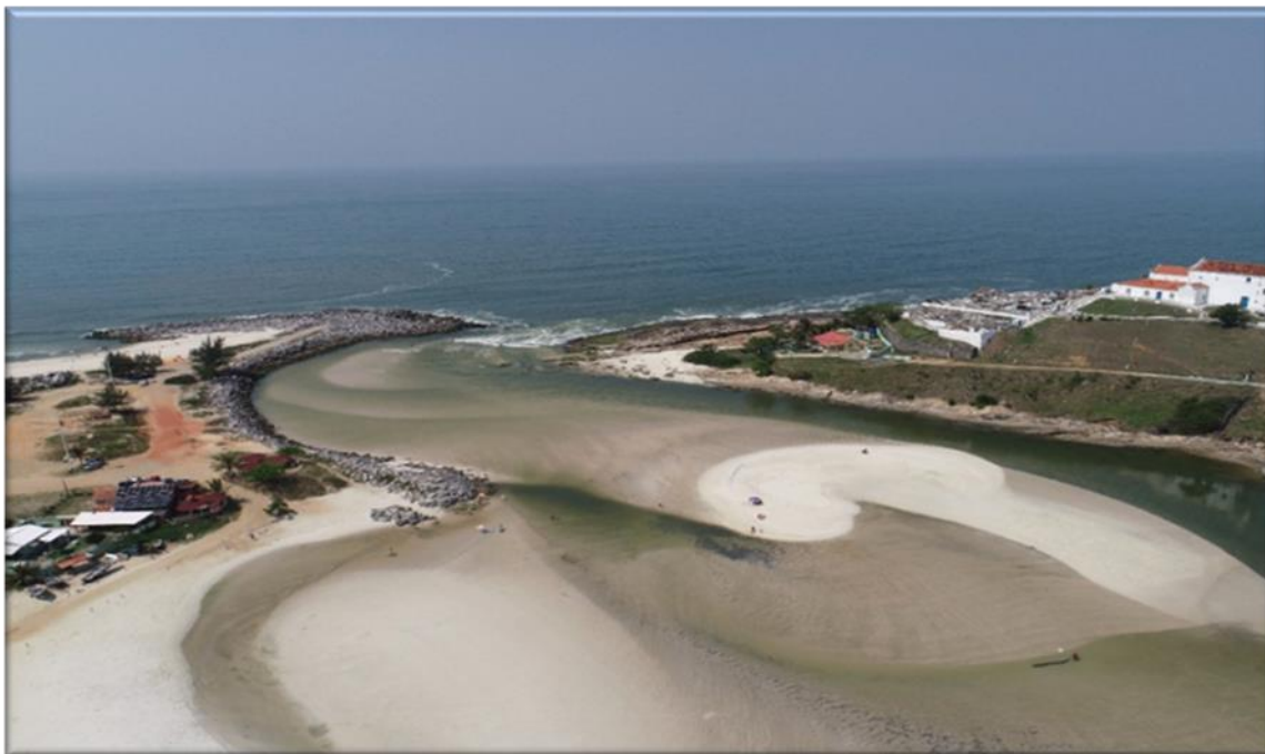
Figura 4- Assoreamento do canal e blocos de pedras na embocadura
